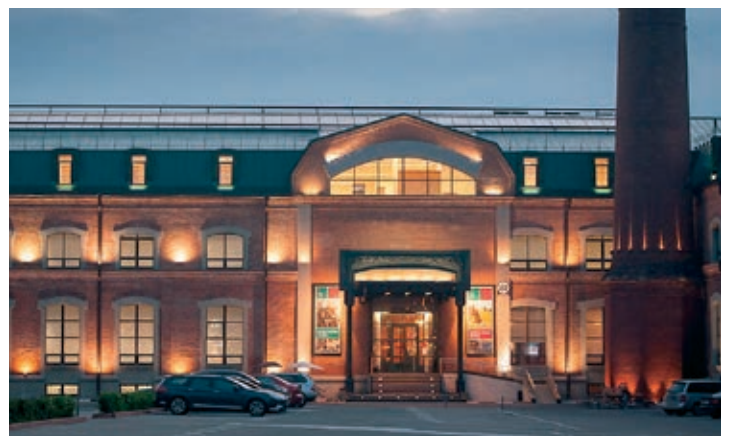
КАРТИННАЯ ГАЛЕРЕЯ / МОСКВА, ДЕРБЕНЁВСКАЯ НАБ., Д. 7, СТР. 31, БИЗНЕС-ЦЕНТР «НОВОСПАСКИЙ ДВОР»
