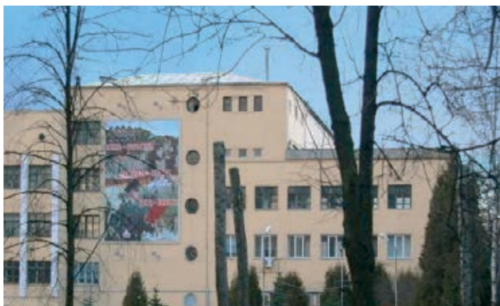
МОСКОВСКИЙ ПОГРАНИЧНЫЙ ИНСТИТУТ / МОСКВА, ОСТАШКОВСКАЯ УЛ., Д. 15
